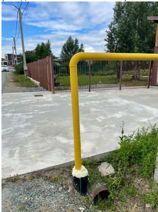
Зачеканка футляров, покраска газопровода
