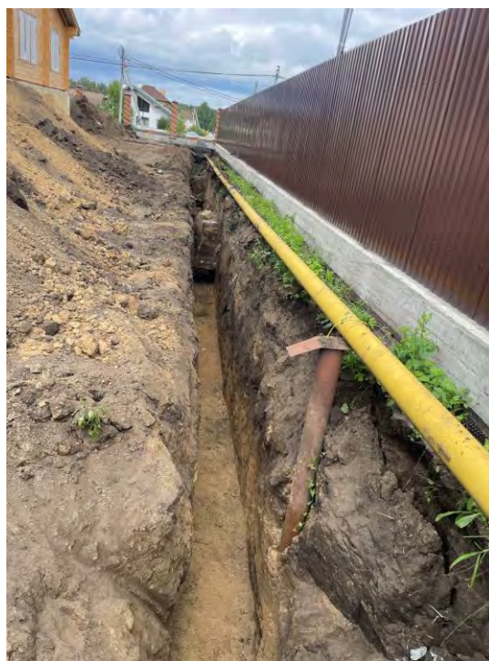
Перекладка газопровода под землю уч.
