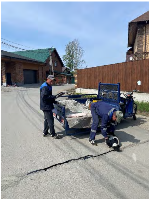
Заделка швов битумной мастикой
